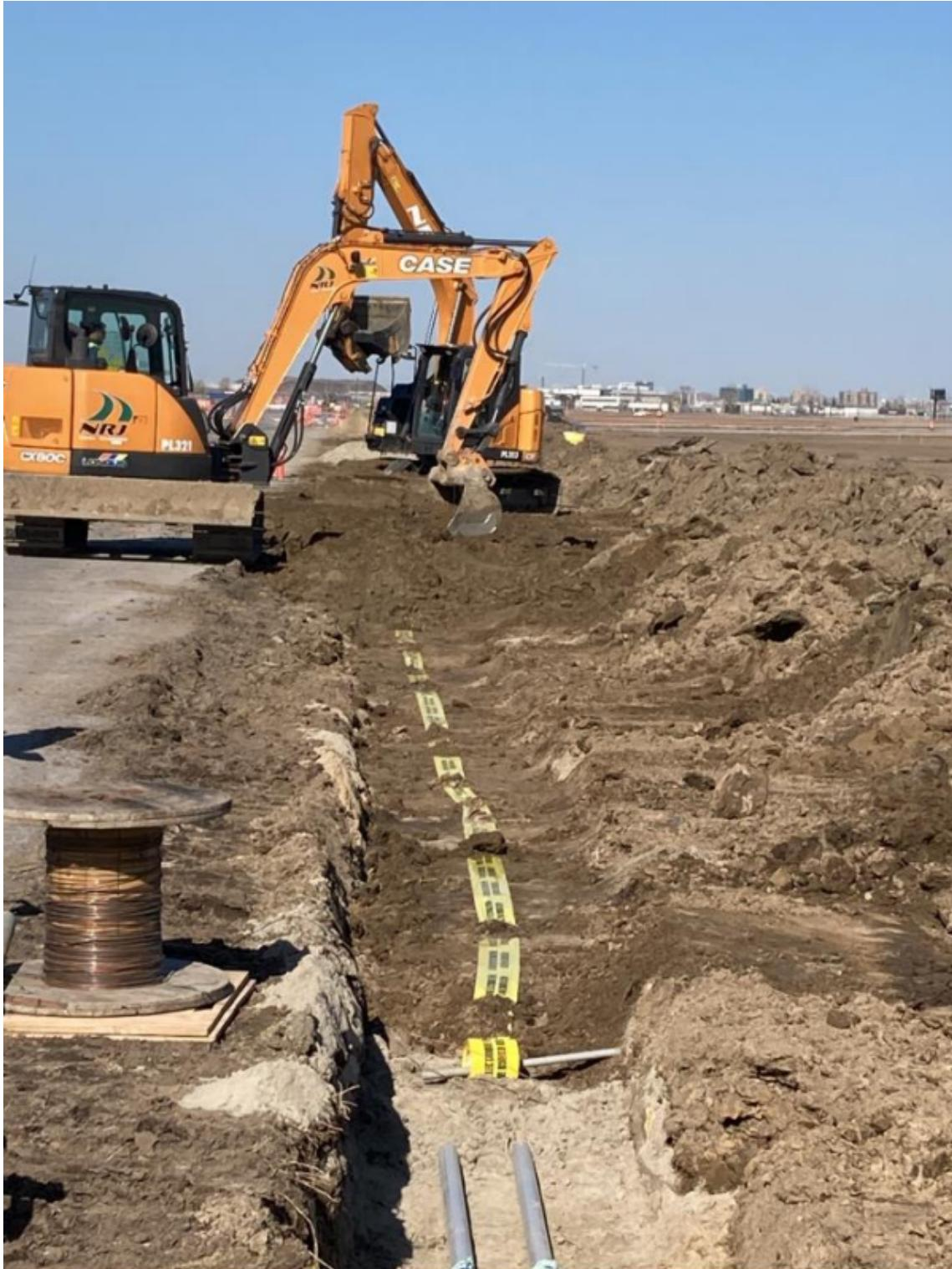
Installation et remblayage de nouveaux conduits de bord de piste
