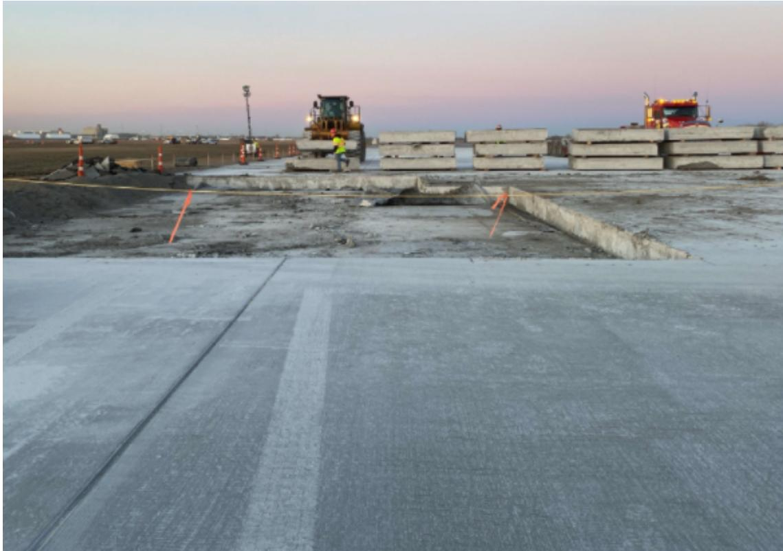
Travaux d'enlèvement des dalles de transition en béton sur la piste
