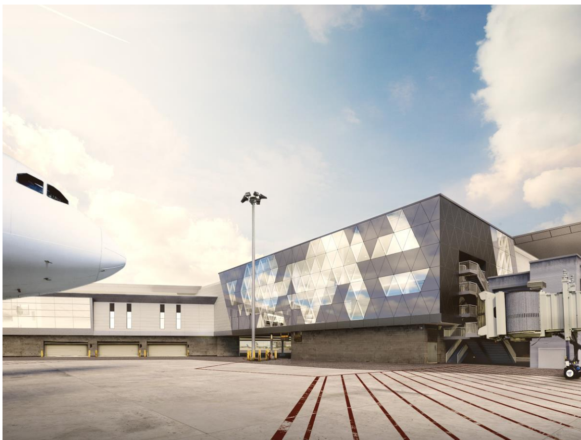
Vue extérieure du centre de correspondance
